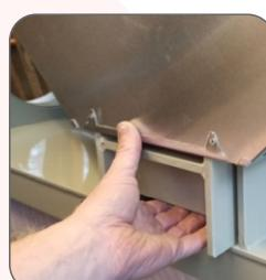
6. Vytáhněte rekuperační výměník pomocí manipulační pásky nebo vozíku.
